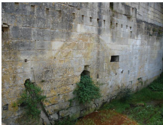
Fig. 4 – Traces de la roue hydraulique sur le haut fourneau de Ménaucourt Photo de l'auteur (septembre 2007)
